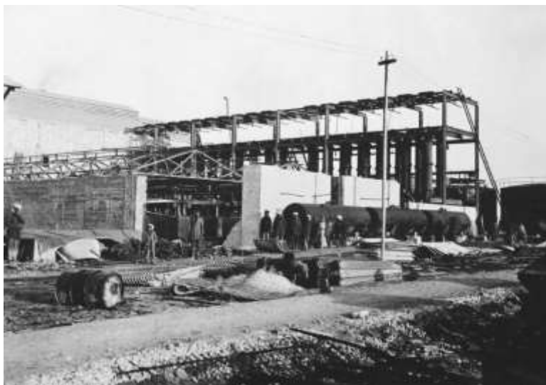
عکس ۴- کارگران در حال ساخت پالایشگاه آبادان در سال ۱۲۹۰
